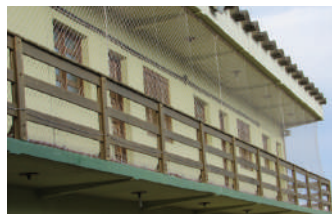
Rede de proteção no Cassino
